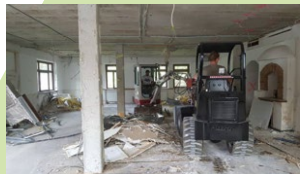
November: Der Medikamentenschrank steht – jetzt kann's an die Feinarbeit gehen.
